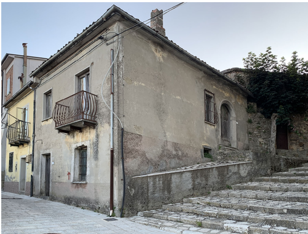
Foto n.1 - Vista immobile angolo via Colmeta - rampa Cuoco
